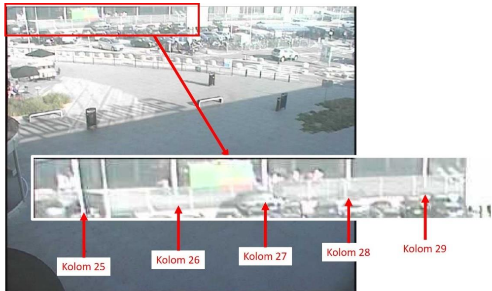
Figuur 4.3: Delen van het MPB die zichtbaar waren op CCTV Dome Terminal Landside 1 [53]
