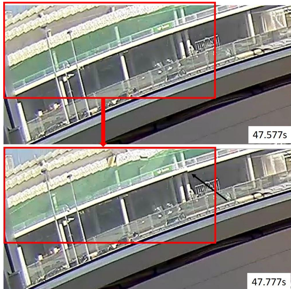
Figuur 4.15: Vloer 2 - 4 verplaatsen naar achteren; vloer 1 draait achter de kolommen omlaag; buitenrand draait daarbij omhoog (pijl geeft gebouwdilatatie aan); kolommen zijn nog niet bezwaken (bovenste beeld is op 47.577s; onderste beeld op 47.777s) [55]
