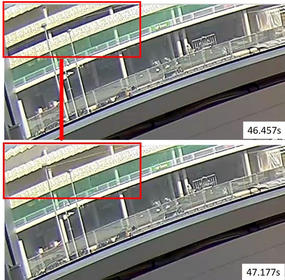
Figuur 4.13: Vloer 4 verplaatst naar achteren; vloer 3 draait achter de kolommen omlaag; buitenrand draait daarbij omhoog; kolommen zijn nog niet bezweken (bovenste beeld is op 46.457s; onderste beeld op 47.177s) [55]
