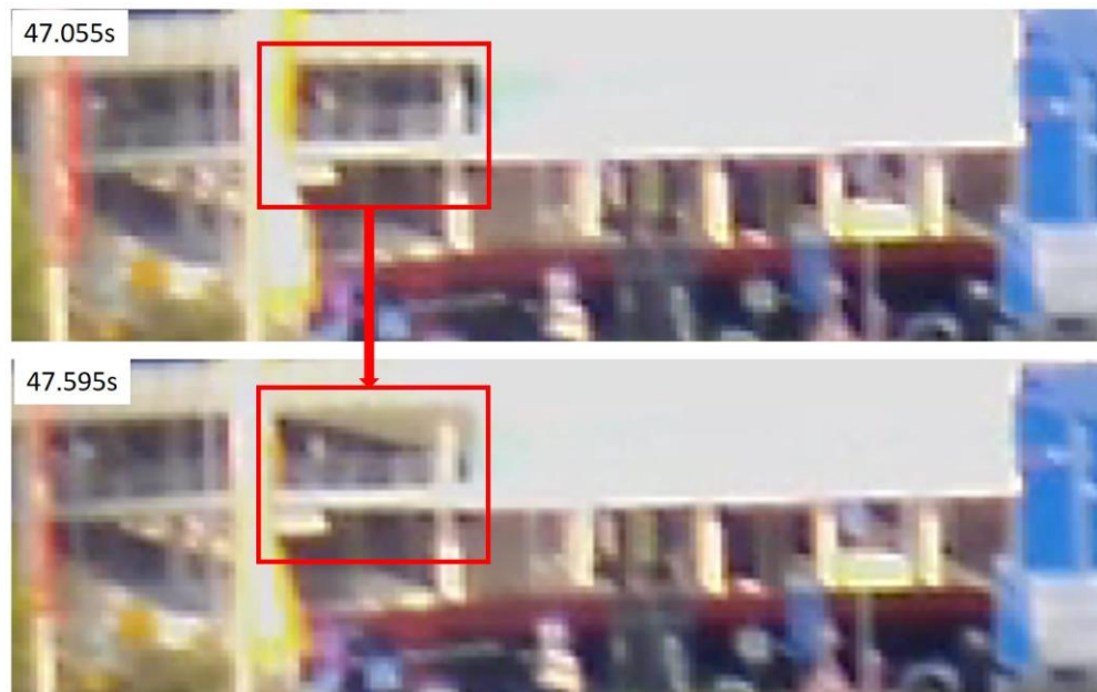
Figuur 4.10: Vloer 2 is omlaag gedraaid en kolom is nog niet bezwaken; rechter deel vloer verder gedraaid dan linker deel (bovenste beeld is op 47.055s; onderste beeld op 47.595s) [54]
