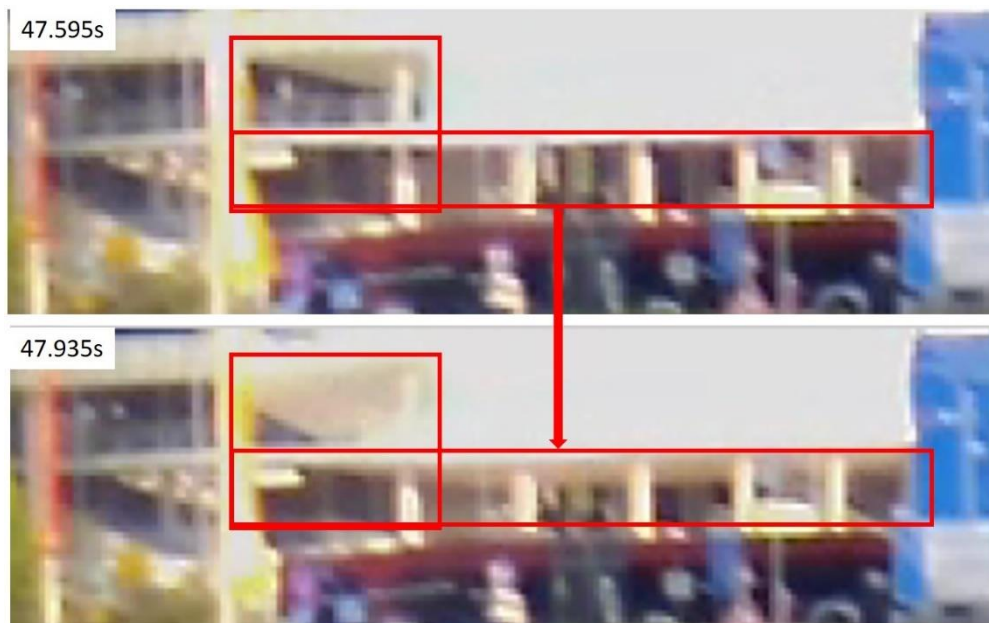
Figuur 4.11: Vloer 1 en vloer 2 zijn omlaag gedraaid en kolommen zijn nog niet bezwaken; rechter deel van vloeren verder gedraaid dan linker deel (bovenste beeld is op 47.595s; onderste beeld op 47.935s) [54]
