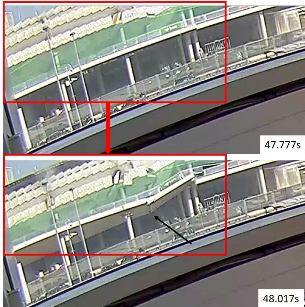
Figuur 4.16: Kolommen bezwijken; in vloer 1 ontstaat breukvlak ter plaatse van naad A (bovenste beeld is op 47.777s; onderste beeld op 48.017s) [55]
