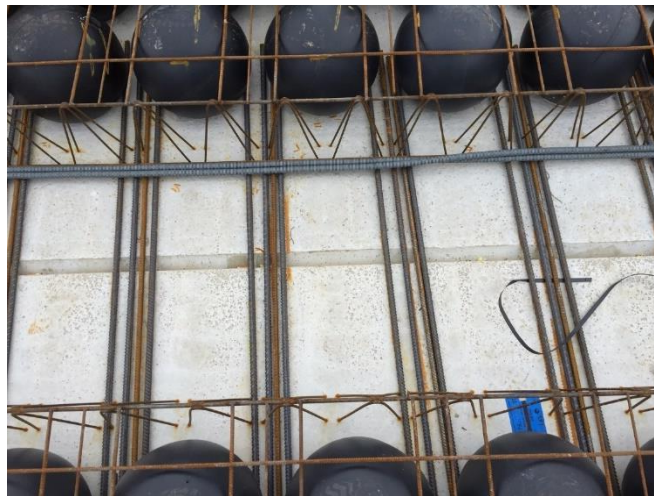
Figuur 7.7: Detail tralieliggers bij koppelstaven in hoofddraagrichting [59]
