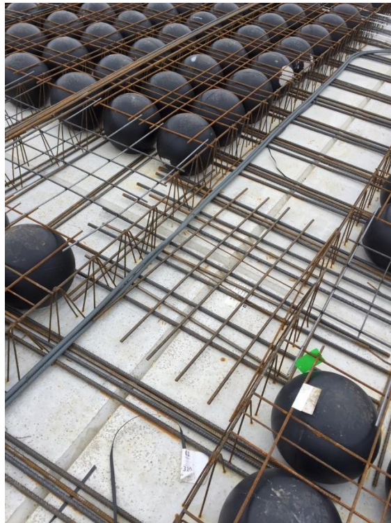
Figuur 7.6: Plaatsing koppelstaven op kruispunt van breedplaten [59]
