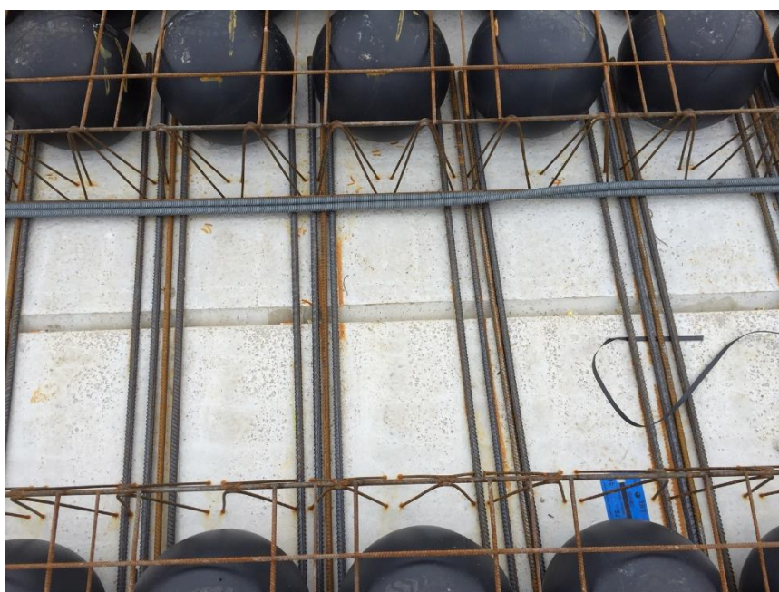
Figuur 7.2: Voorbeeld mogelijkheden voor plaatsing koppelstaven en daarbij optredende mogelijke gebundelde plaatsing (foto gemaakt op 7 oktober 2016 in het onderhavige gebouw)
